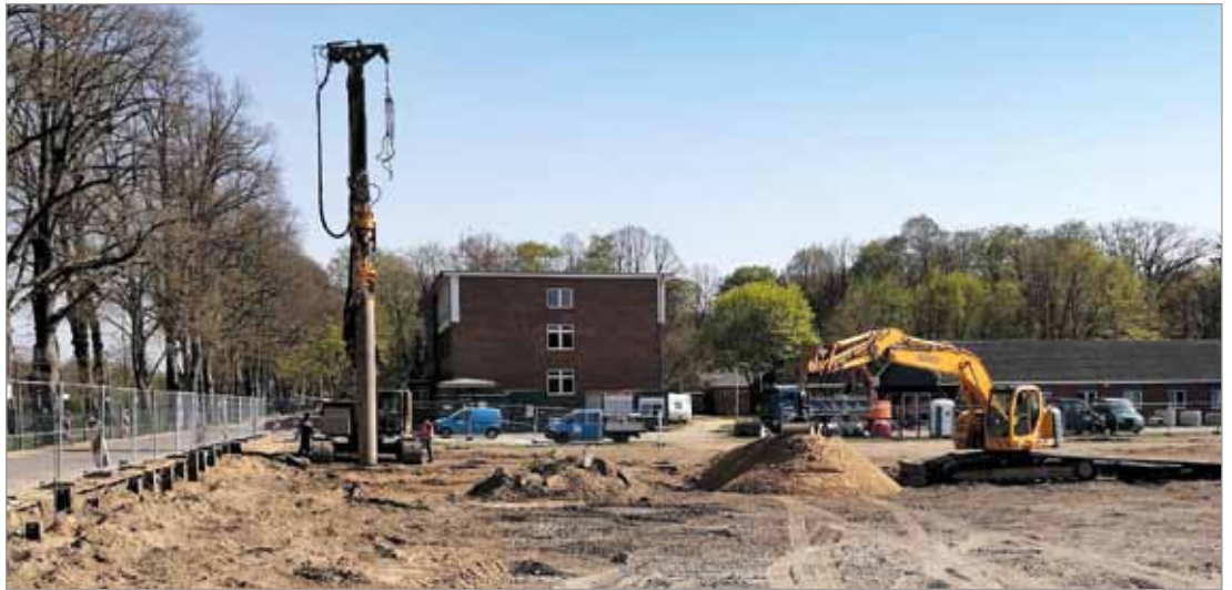
Spatenstich am 15.04.2019 Foto: F. Petersen
